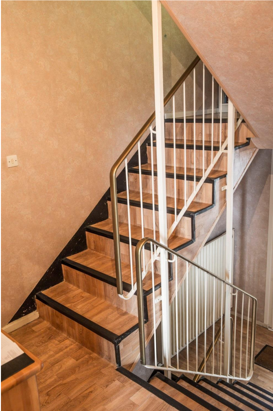
Escalier préfabriqué dans une des maisons des Sablons.
