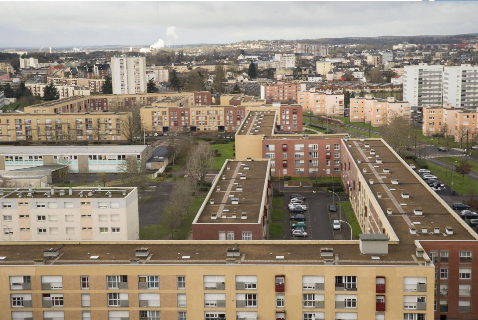
Vue des barres de la première tranche, Sablons ouest.
